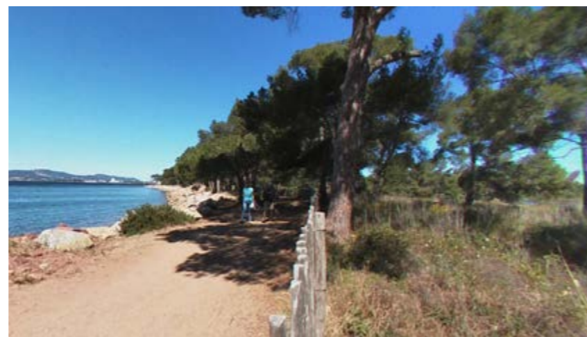
Enrochement le long de la promenade littorale
