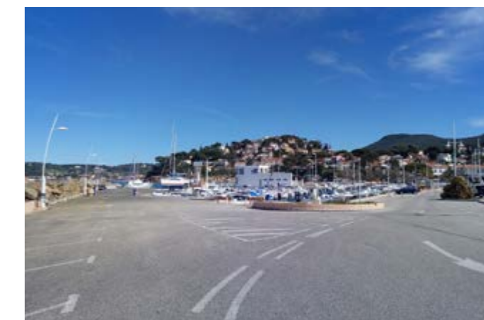
Port de plaisance des Oursinières, le Pradet ©Caudex
