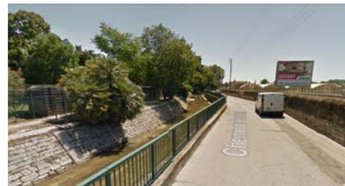
Le Roubaud canalisé
